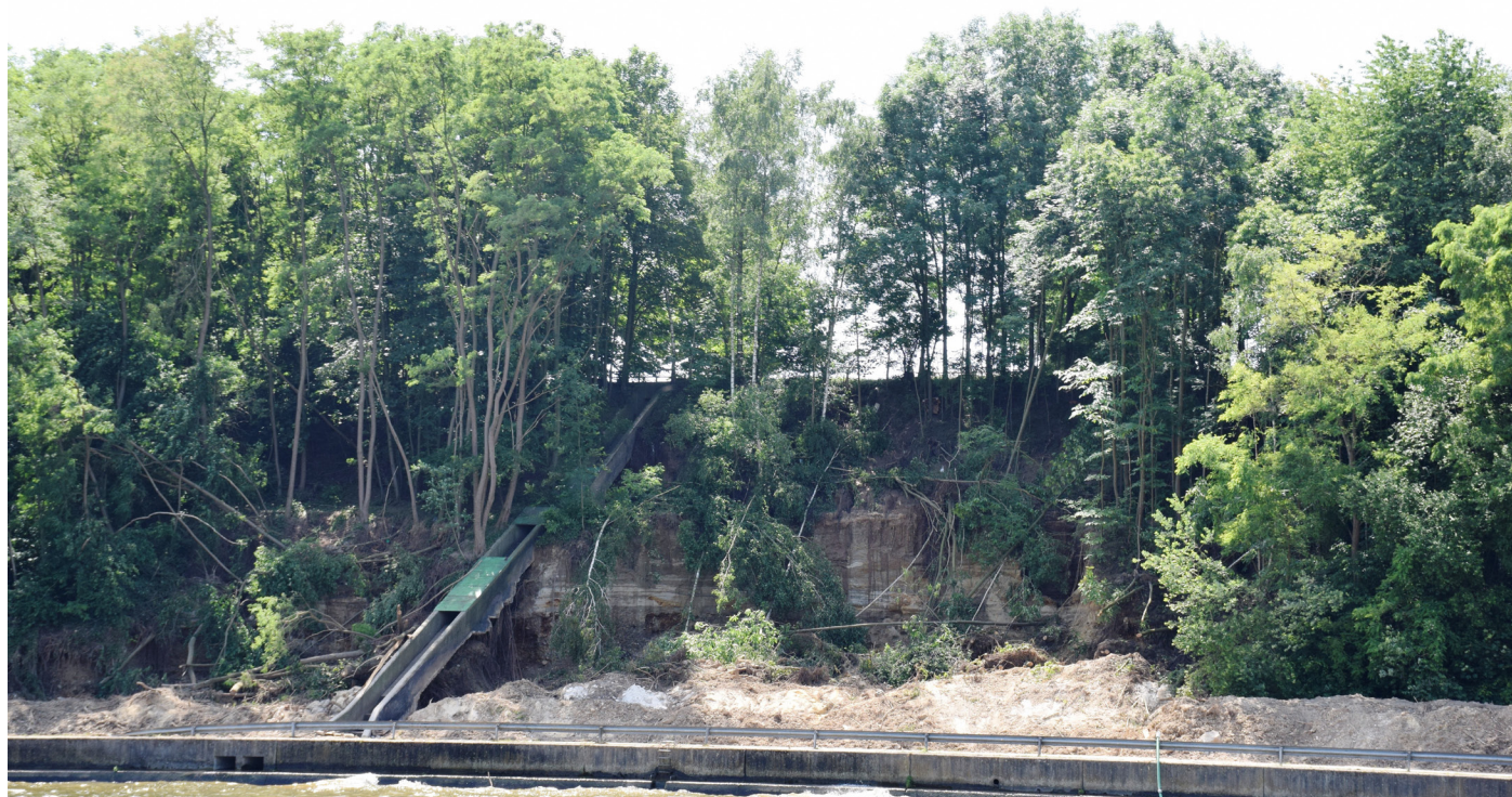
Fig. 1 Zicht op het geologisch kijkvenster (gevolg van afglijding) vanaf de oostelijke oever van het Alberkanaal (9 juni 2016)
