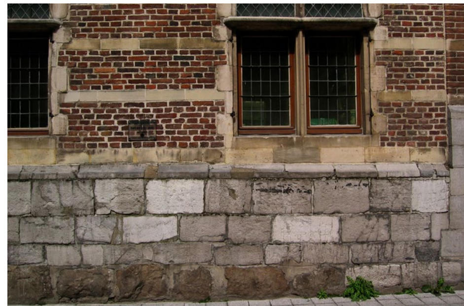
Figuur 27. Ondermuur van de Herkenrodekazerne in Hasselt, met helemaal onderaan grote blokken van Boderiaanzandsteen
